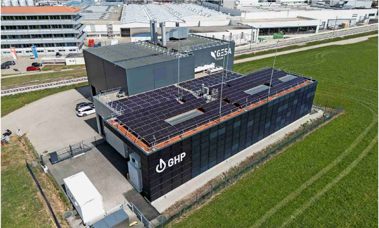
Le bâtiment de Gruyère Hydrogen Power, à Bulle (FR), jouxte l'un des points d'alimentation du chauffage à distance de Gruyère Energie. Au second plan, l'usine de Liebherr Machines Bulle SA, où sont mis au point des moteurs à hydrogène.
