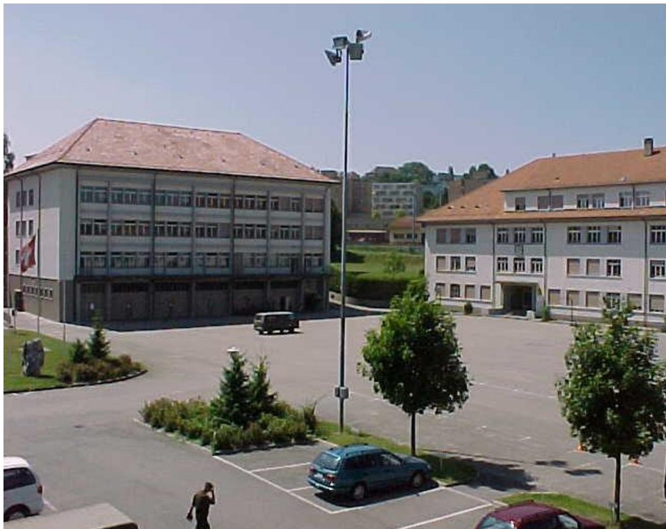
Abandonnée depuis des années, l'ancienne caserne sert de laboratoire d'urbanisme et d'architecture pour la formation des professionnels de la construction.
