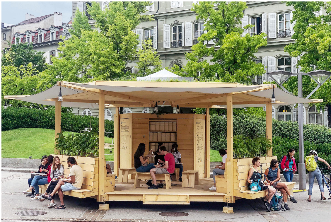
Le pavillon installé en juillet 2021 sur la place Python à Fribourg. Diamètre de la toiture avec le prolongement des toiles d'ombrage: 10 m, hauteur entre le plancher et la toiture: 2,5 m, hauteur maximale : 3,8 m. Sa structure modulaire permet de le démonter, le transporter puis le remonter sur un nouvel emplacement en ~1,5 jours.
