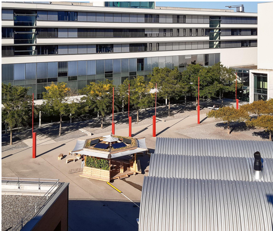
Le pavillon installé en septembre 2021 sur le campus UNI-FR+HEIA-FR de Pérolles à Fribourg. Cet emplacement très minéral est connu pour devenir particulièrement chaud en période estivale.
