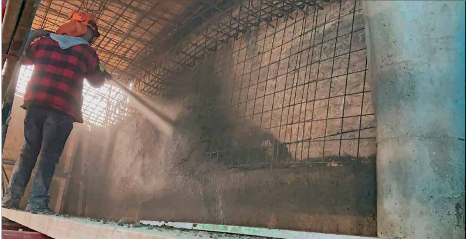
Le système de terre crue projetée mis au point par l'entreprise Pittet Artisans Sàrl fait l'objet d'un projet de recherche de la Haute Ecole d'ingénierie et d'architecture de Fribourg et de la Haute Ecole d'ingénierie et de gestion d'Yverdon. PITTET ARTISANS SÀRL
