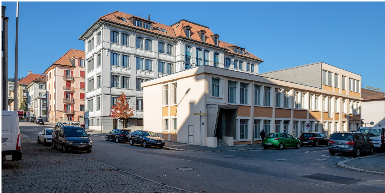
Les contraintes sont nombreuses pour l'assainissement du parc immobilier à La Chaux-de-Fonds: Unesco et urbanisme innovant à son origine confèrent un statut architectural particulier à cette ville d'altitude.
